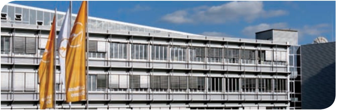
Rechenzentrum von Lufthansa Systems: Durch ein umfangreiches Modernisierungsprojekt konnte eine wesentliche Steigerung der Energieeffizienz erzielt werden.
